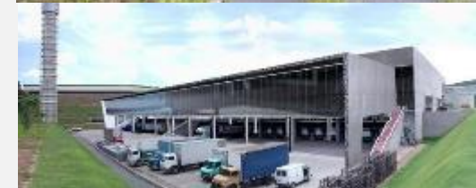
NATURA – AMPLIAÇÃO PICKING CAJAMAR SP
