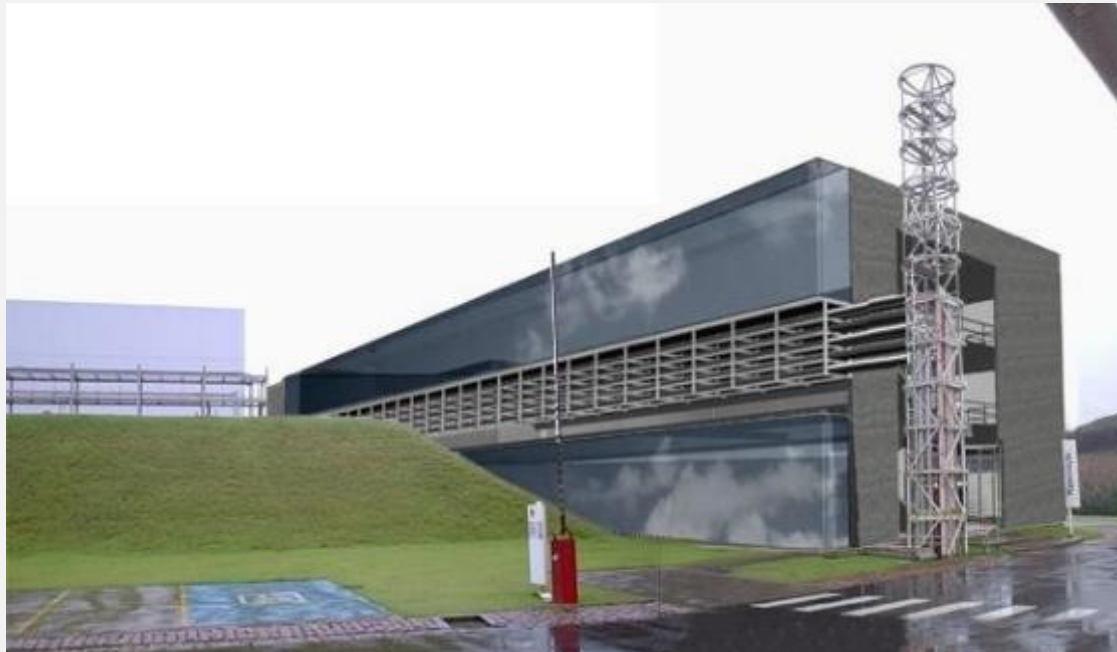
NATURA - EDIFÍCIO SHELF LIFE / ENGENHARIA CAJAMAR SP
