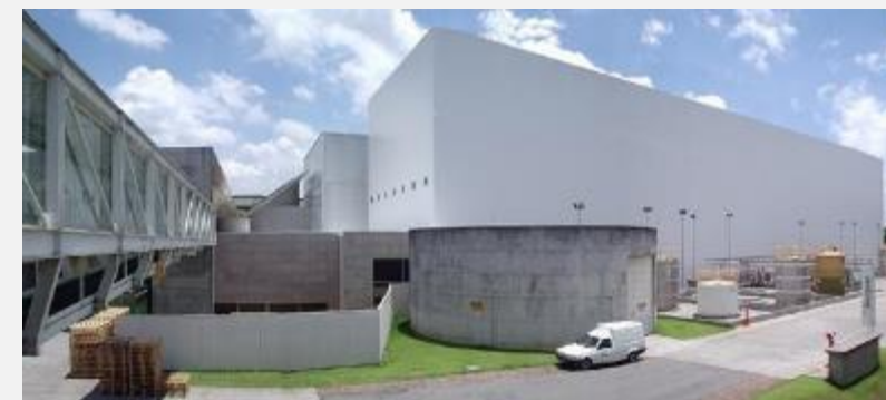
NATURA – EDIFÍCIO AV2 - ARMAZÉM VERTICAL 2 CAJAMAR SP
